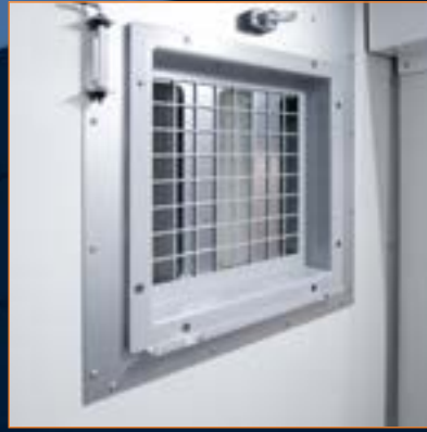
HEPA-LUFTFILTRATION Kontrollierter Luftwechsel und -führung
