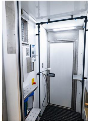
Desinfektionsbereich im Unterdruck mit Dusche und Sprühdeseinfektion
