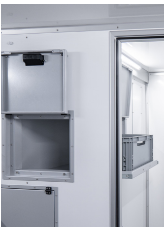
Schleuse für Wechselkleidung
