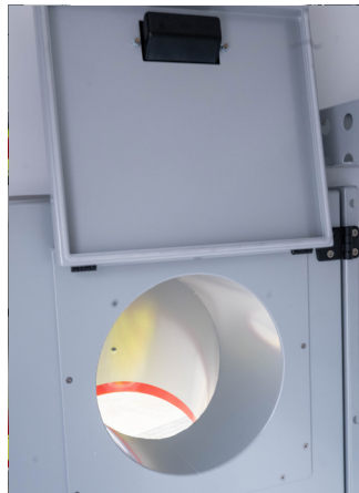
PSA-Auswurf im Schwarzbereich
