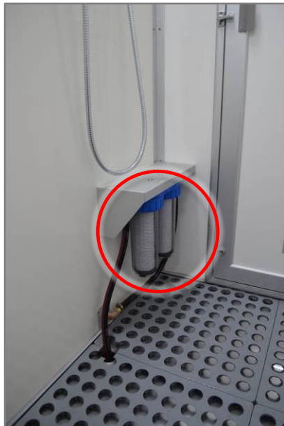
Abb. 112 Filtro de aguas residuales
