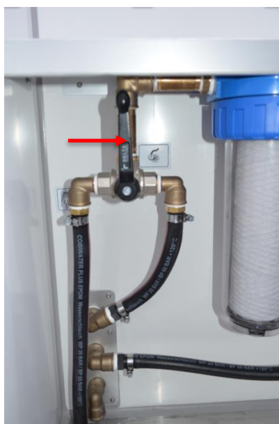
Abb. 23 Posizione della valvola a sfera per la filtrazione delle acque reflue
