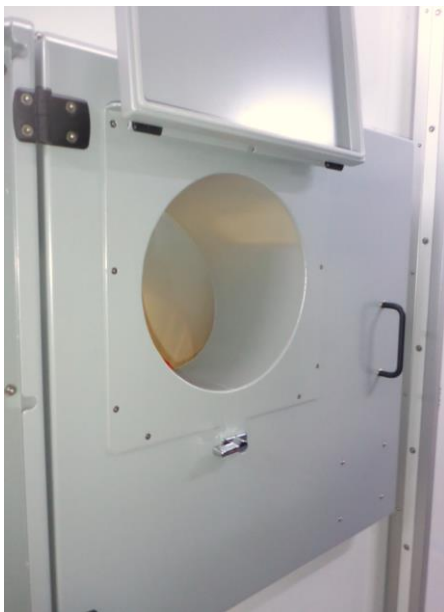
Abb. 27 Vano di raccolta indumenti contaminati
