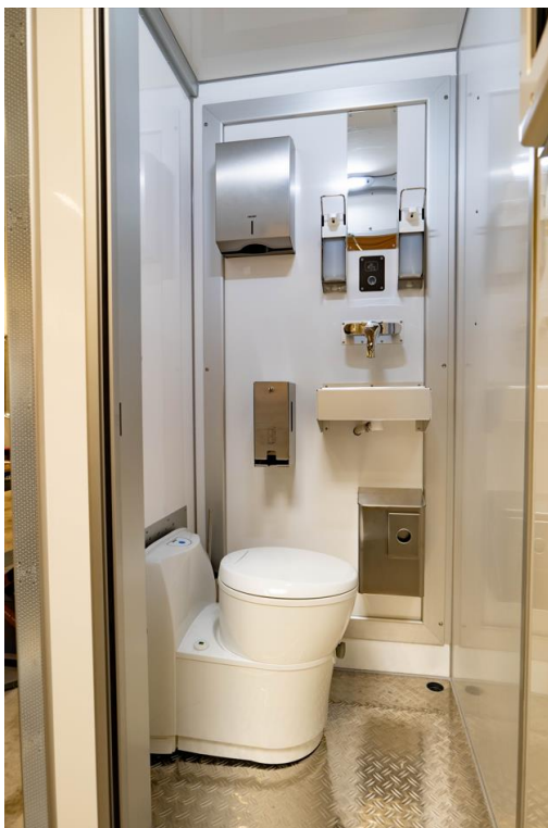
Abb. 31 Locale servizi igienici nella zona posteriore
