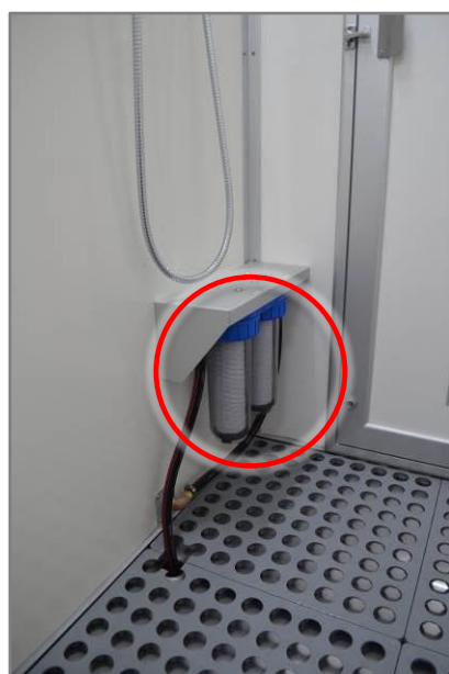
Abb. 112 Filtre d'eaux usées
