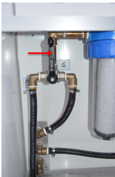
Abb. 23 Position du robinet à boisseau sphérique pour la filtration des eaux usées
