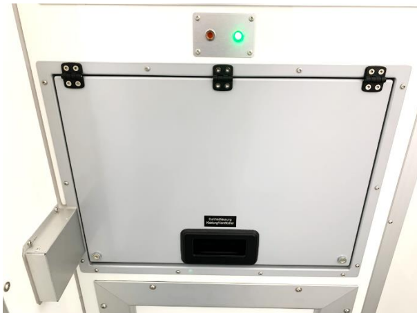
Abb. 28 Kleiderschleuse mit Signallampen bei rot: nicht bereit und grün: für bereit
