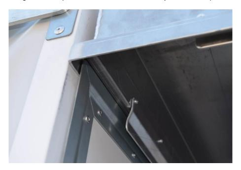
Inserte los elementos de pared de la cámara de ducha en las guías del elemento de piso y al mismo tiempo asegúrese de que los perfiles angulares encajen detrás del perfil de guía de las cámaras.
