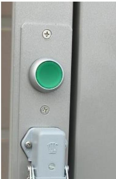
Über eine Notentriegelung, z. B. bei Stromausfall, können die Türen im Notfall geöffnet werden. Die Notentriegelung ist gegen unbeabsichtigtes Öffnen gesichert.
