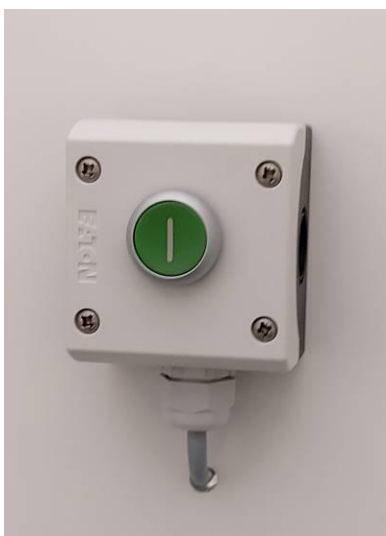
Caja de interruptores
