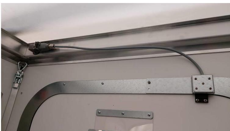
Raccorder le câble du connecteur de l'élément de toit au-dessus de la porte Zone propre à l'entrée "1" du générateur d'air.
