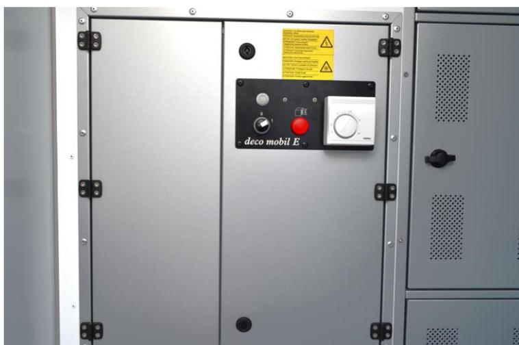
Abb. 6 Interrupteur et thermostat pour le chauffage de la pièce dans la zone verte
