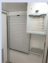
Extracteur d'air avec filtration HEPA
