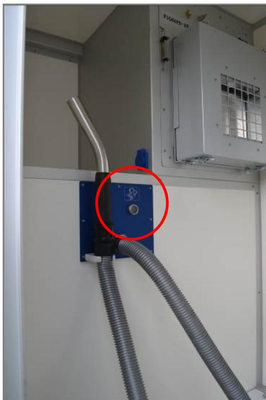
Fig. 12 Pulsador para la activación del aspirador (círculo rojo)
