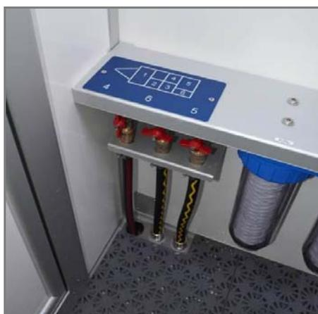
Fig. 123 Conexiones de las cámaras 4-6 al sistema de filtrado de aguas residuales
