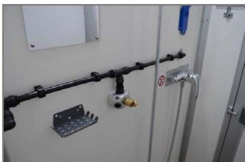
Fig. 125 Conexión de aire comprimido
