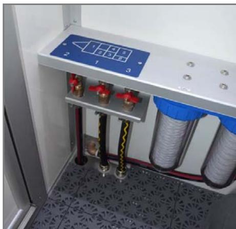
Fig. 122 Conexiones de las cámaras 1-3 al sistema de filtrado de aguas residuales
