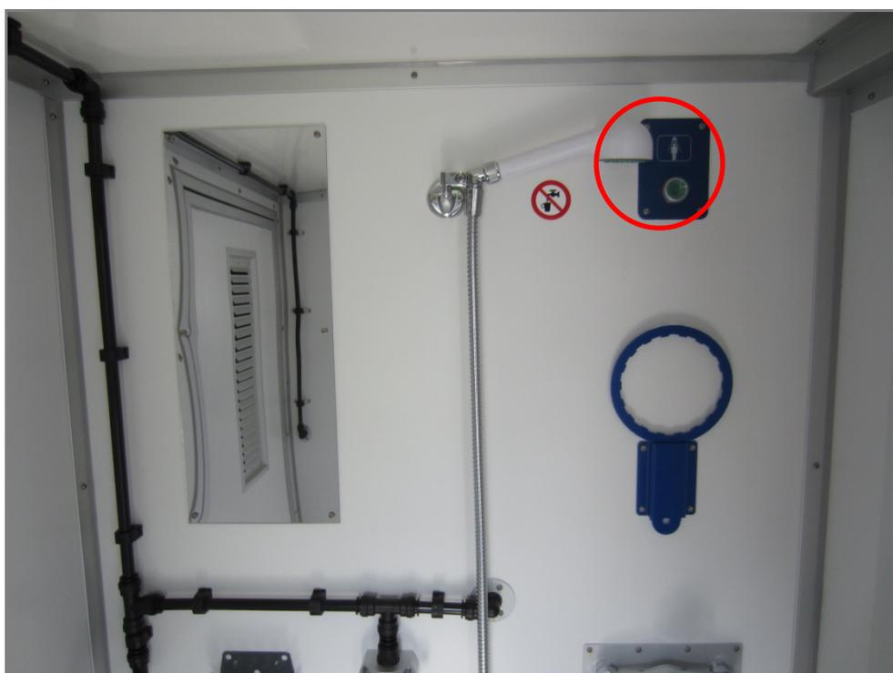
Fig. 11 Pulsador para la activación de la ducha (círculo rojo)
